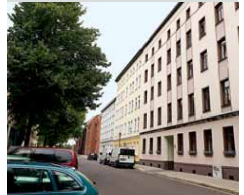
>>> Das Mietshaus wurde saniert, aber der TV-Empfang blieb zunächst schlecht.
