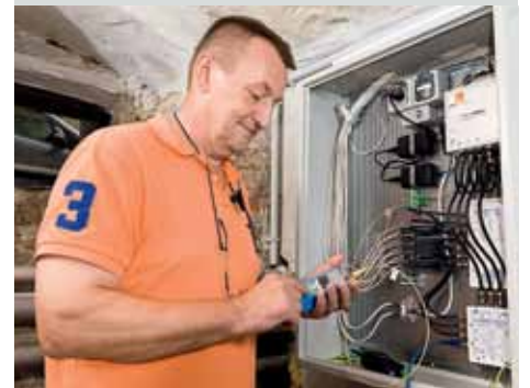
>>> Kompakte Technologie: Ein Techniker beim letzten Check nach dem Einbau.
